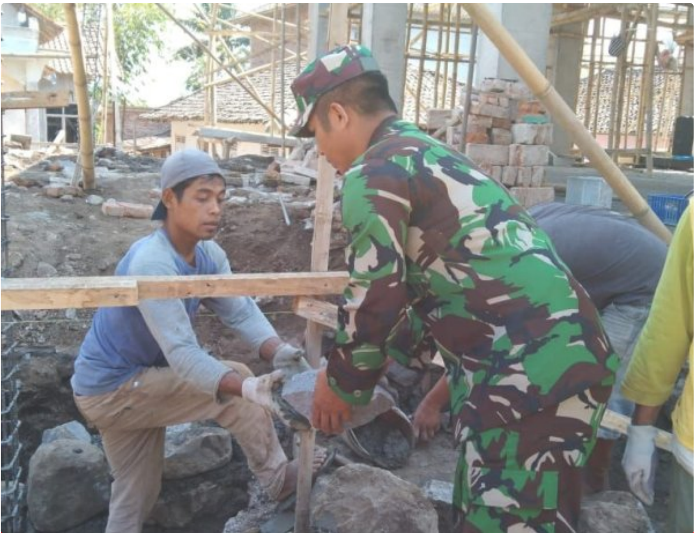
Serda Nasikin bantu pemasangan batu pondasi masjid
